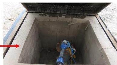
(右) 水道場の下もコンクリートで固められ、足元土ドロドロが避けられます。
