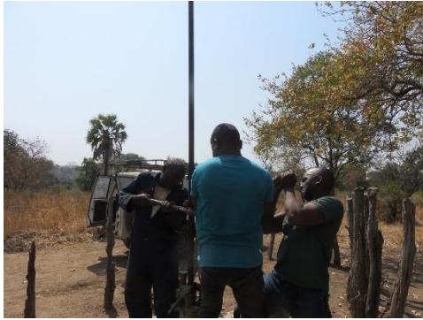
＊パイプの抜き取り作業
